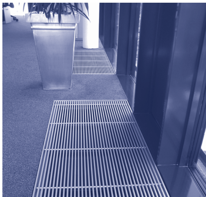
TROX podlahová indukční vyúst' série BID s lineární mřížkou
