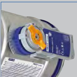
Servopohon s mechanickými dorazy
